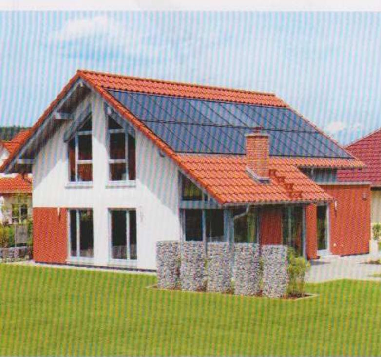
Außen sichtbar: der Fertigschornstein mit klassischer Klinkeroptik. Finger-Haus
