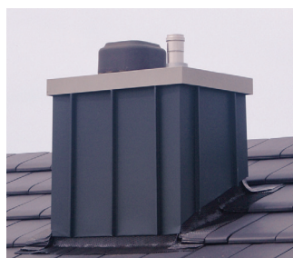
Kopfabschluß 2-zügig: Abdeckplatte Edelstahl lackiert, Mündungshaube Keramik in Sonderfarbe.
