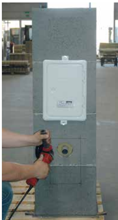
5. Mantelstein mit einem Trennschleifer entlang der angezeichneten Linien einschneiden
