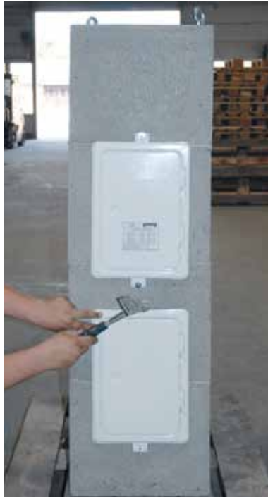
8. Türe einpassen und mit Nägeln fixieren.
