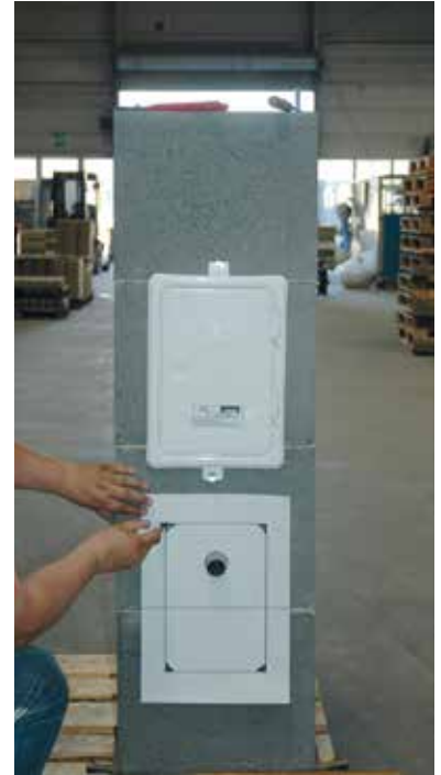
3. Ausschnitt-Ecken mit einem Stift kennzeichnen
