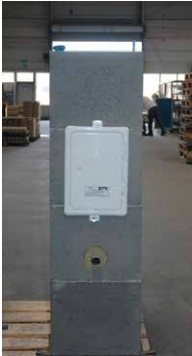
1. Fertigfuß aufstellen und ausrichten.
